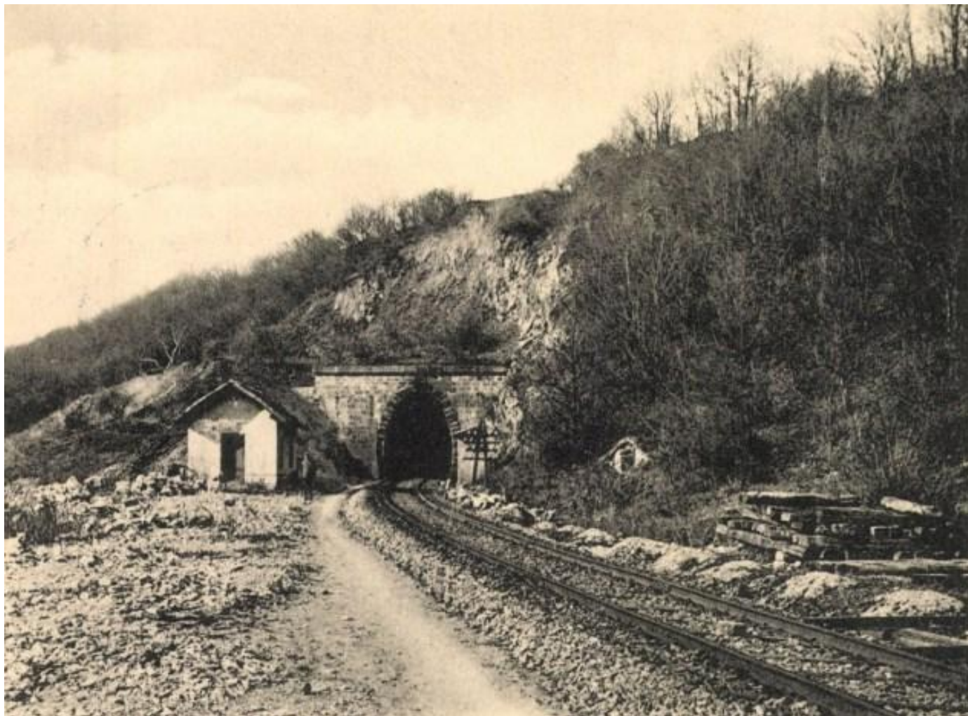
Obr.3: Južný portál starého Ťahanovského tunela
