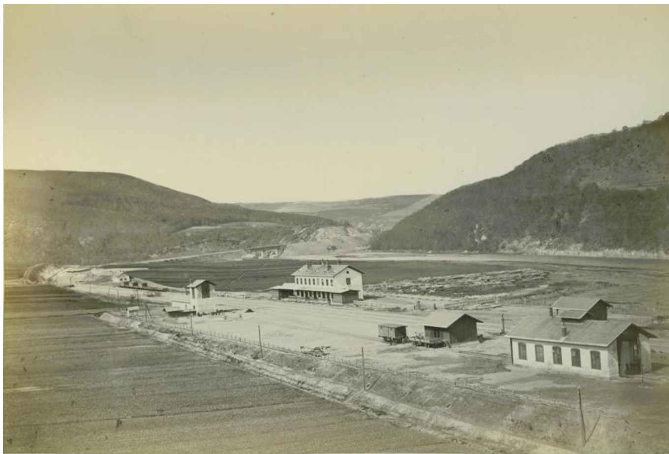
Obr.2: Stanica Kysak v čase výstavby, okolo roku 1870
