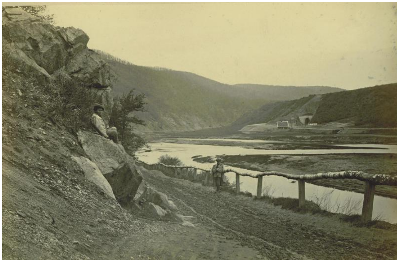
Obr.4: Cesta popod Hradovú, v pozadí Ťahanovský tunel
