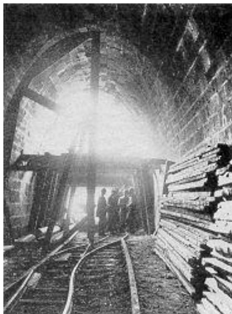
Obr.6: Oprava vojnou zničenej klenby starého Ťahanovského tunela
